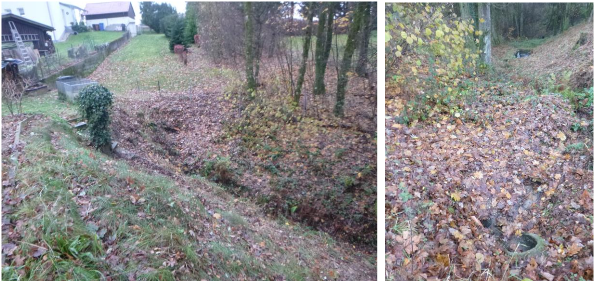
Bild 4: Auslauf des bestehenden Kanals auf dem Flurstück 633
