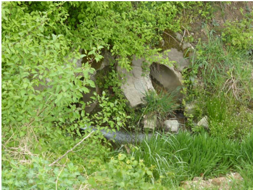
Fotos 1 und 2: Ansicht RA1 (derzeit Baustelle Neubau Schöpfwerk Metten)
