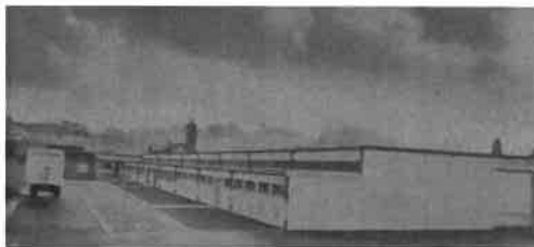
neue Fabrikhalle, jetzige Böhmssiedlung
