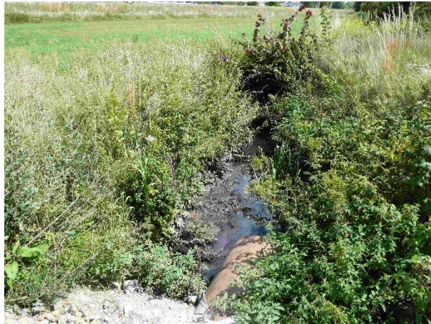
Abbildung 3: Graben nach Durchlass
