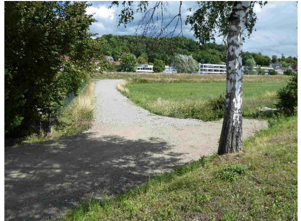
Abbildung 4: Schotterzufahrt im Norden
